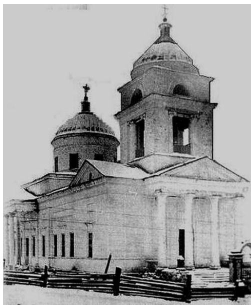
Церковь Троицы Живоначальной. Село Кизнер, 1835-1858 гг. Фото 1939 г. ЦГА УР, ф. 120, фотофонд № 05873
