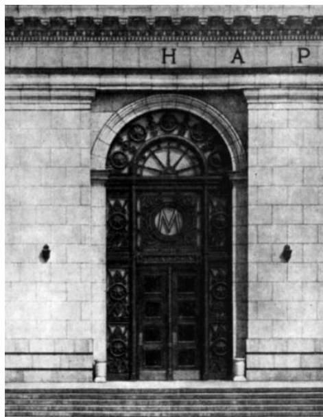
Иллюстрация 10. Входной портал станции ленинградского метро «Нарвская», 1957 г. Фото из книги А. М. Соколова «Станции Ленинградского метро», 1957 г. (Соколов, 1957)
