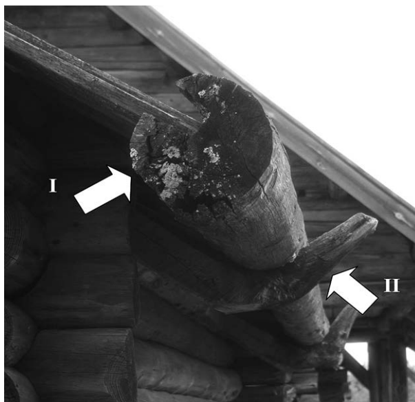
Рис. 1. Куала. Конструктивные особенности самцовой кровли: I – поток и II – курицы. Архитектурно-этнографический музей-заповедник «Лудорвай». Фото Е. В. Овчинниковой
