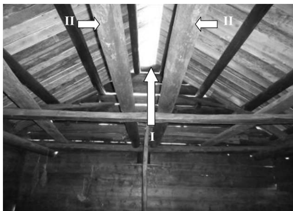
Рис. 3. Куала. Конструктивные особенности: I – волоковая щель, II – направляющие балки ошона. Архитектурно-этнографический музей-заповедник «Лудорвай». Фото Е. В. Овчинниковой
